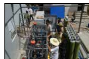
含铬电镀废液回收利用
